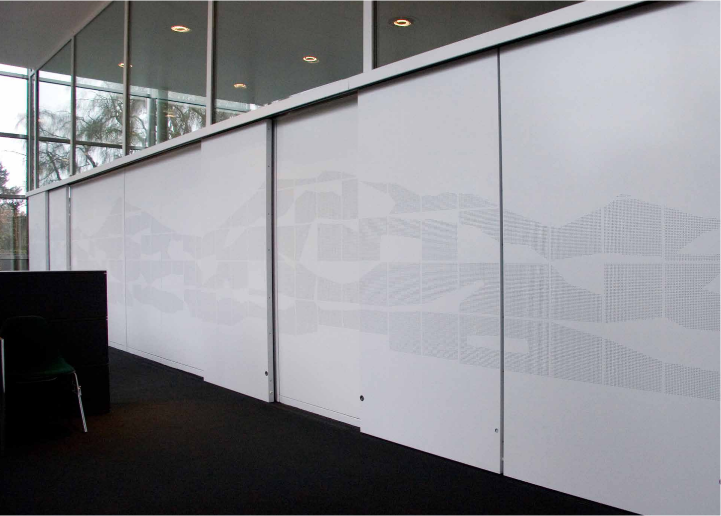
Abdankungshalle Rosengarten Empfang Material: Akustiklochplatten, weisses Vlies
