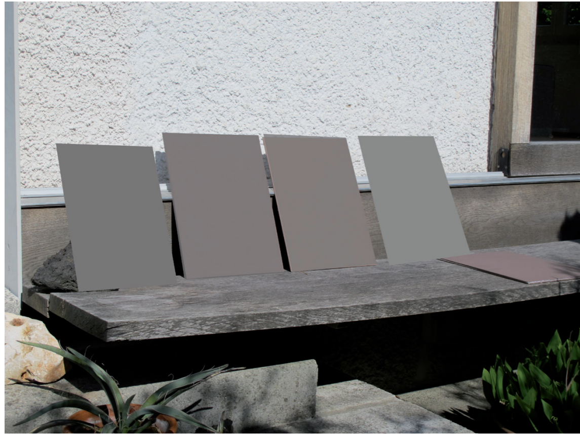
Farben für die Fassade vor Ort überprüfen und anpassen
